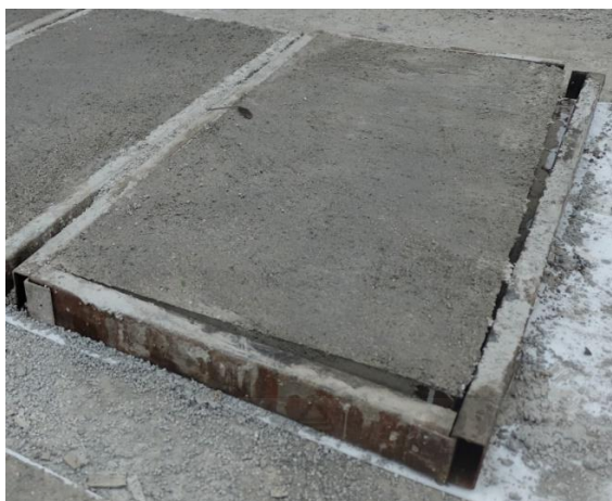
รูปที่ 3.17 ถอดแบบผนังคอนกรีต
