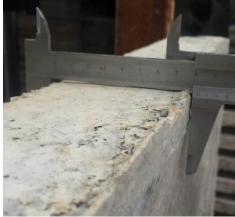
รูปที่ 4.2 การวัดขนาดของผนังคอนกรีตผสมกากดินขามวลรวมละเอียดสำหรับก่อสร้างอาคาร ประหยัดพลังงานแบบสำเร็จรูป
