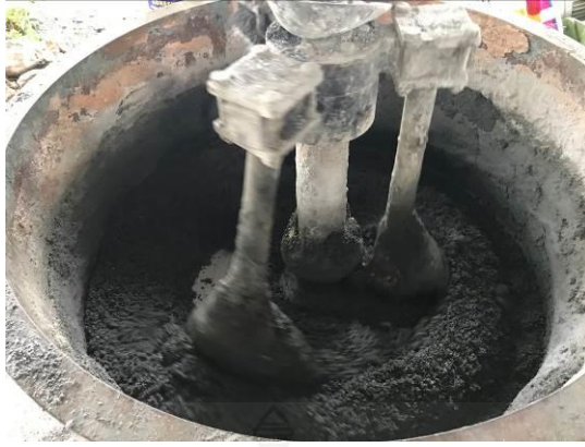
รูปที่ 16 การผสมส่วนผสมที่เติมน้ำประปาและสารเคมีผสมเพิ่มแล้วให้เข้ากันด้วยเครื่องผสมคอนกรีต
