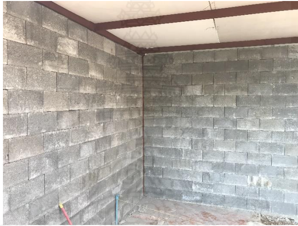
รูปที่ 34 ผนังอาคารที่ก่อด้วยคอนกรีตบล็อกผสมเศษต้นมันสำปะหลัง
