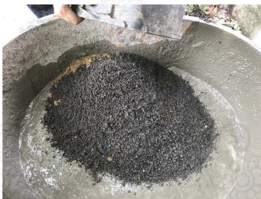
รูปที่ 3.13 การเทหินฝุ่นลงในเครื่องผสมคอนกรีต
