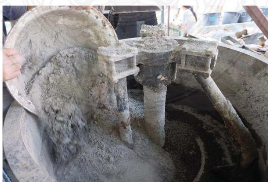
รูปที่ 3.14 การเทปูนซีเมนต์ลงในเครื่องผสมคอนกรีต
