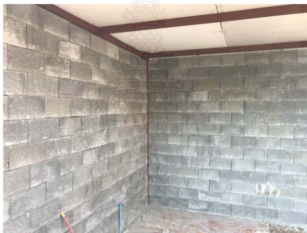
รูปที่ 4.12 ผนังอาคารที่ก่อด้วยคอนกรีตบล็อกผสมเศษต้นมันสำปะหลัง
