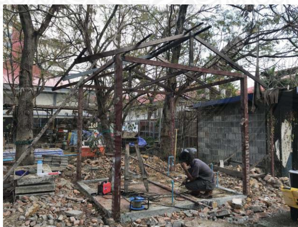
รูปที่ 4.10 โครงสร้างอาคารขนาด 2.5 x 2.5 เมตร สูง 2.5 เมตร สำหรับก่อผนังด้วยคอนกรีตบล็อกผสมเศษต้นมันสำปะหลัง
