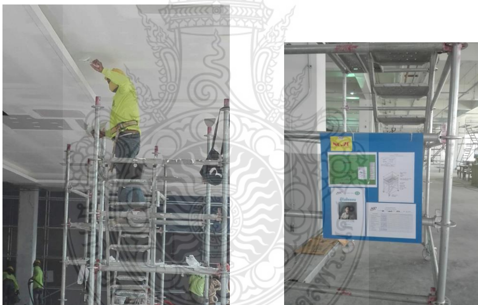
รูปที่ 4.5 มาตรการความปลอดภัยในการทำงานติดตั้งฝ้าเพดาน
