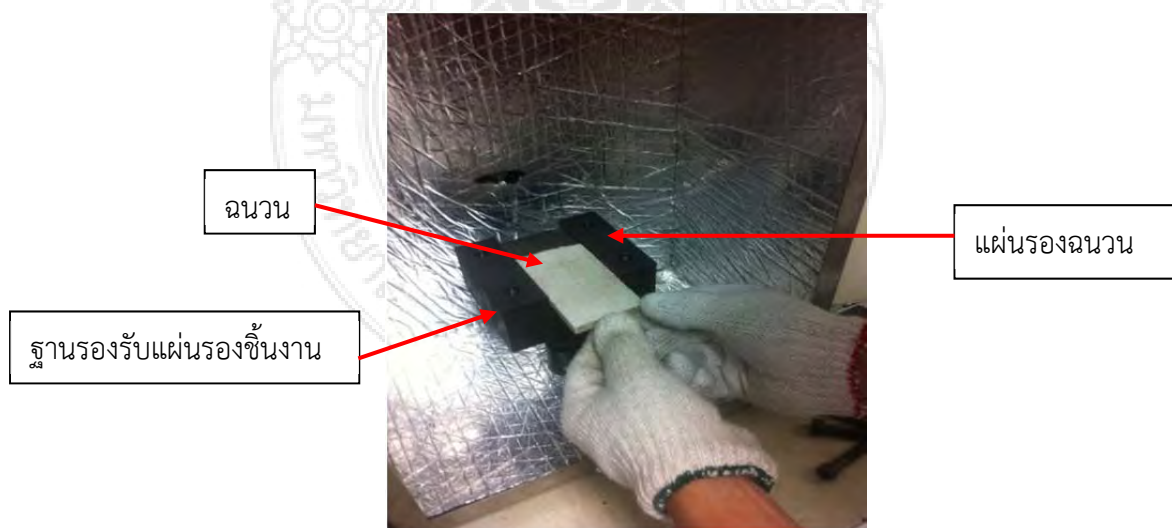
รูปที่ 3.16 การติดตั้งฉนวนเข้ากับแผ่นรองฉนวน
