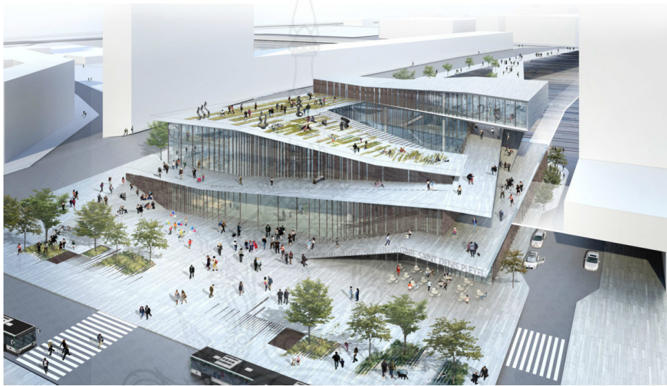
ภาพ 2.2 สถานีรถไฟฟ้าความเร็วสูง Saint - Denis Pleyeblematic Train Station ภายนอก 2 ที่มา: https://dsignsomething.com
