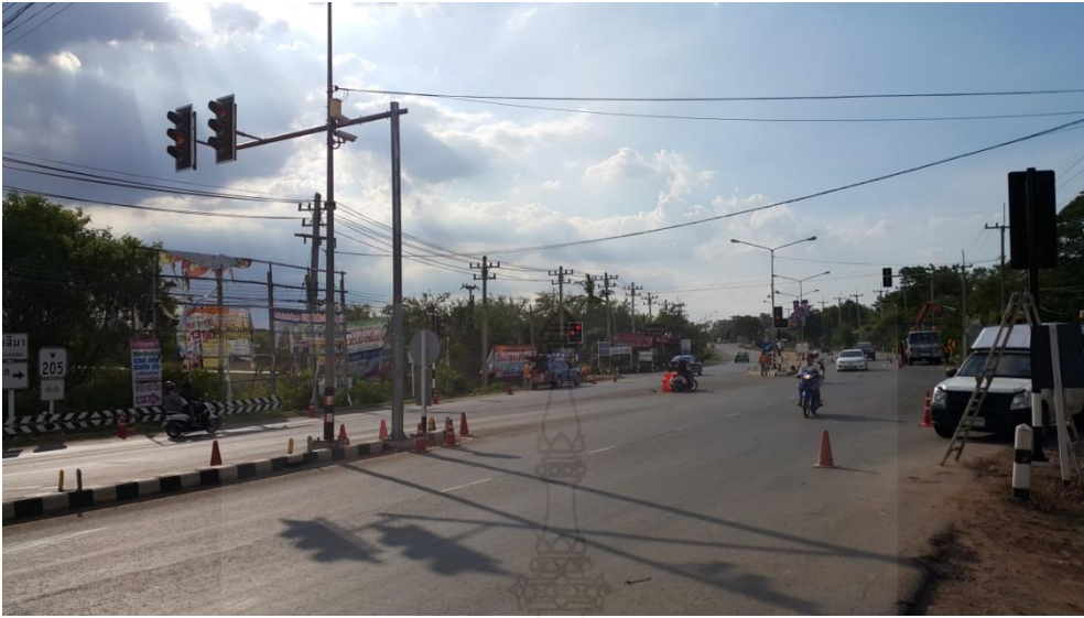
ภาพที่ 3.8 งานติดตั้งไฟสัญญาณจราจร
