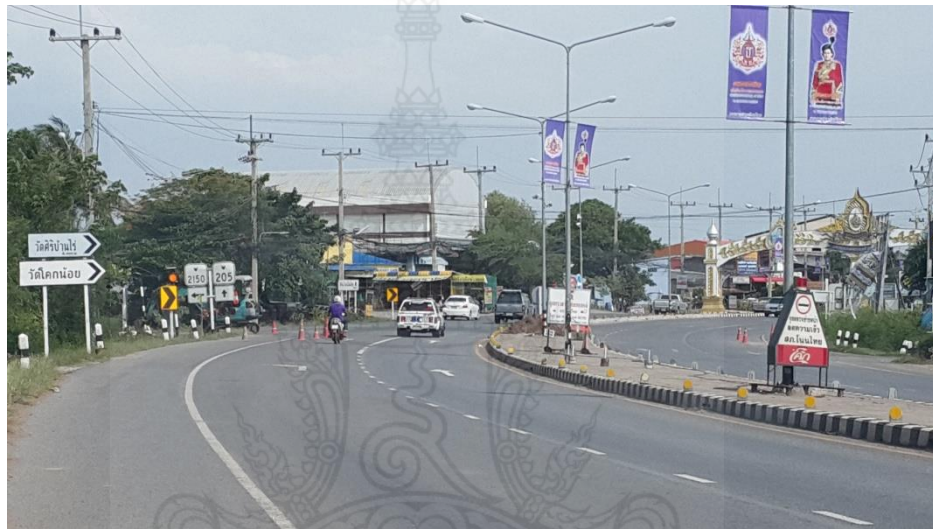
ภาพ 3.7 ทางหลวงบริเวณแยกขามสะแกแสงก่อนทำการปรับปรุง
