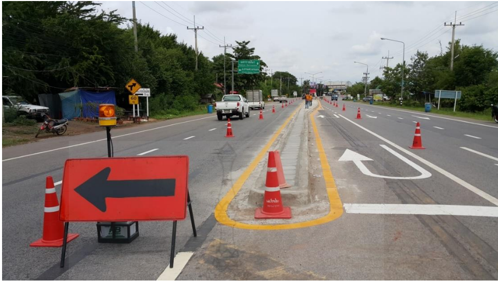
ภาพ 3.12 การตีเส้นสีแบบ Thermoplastic-road-marking ตามแบบ
