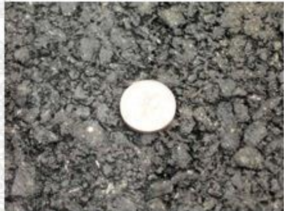
(d) Surface of AR Pavement
