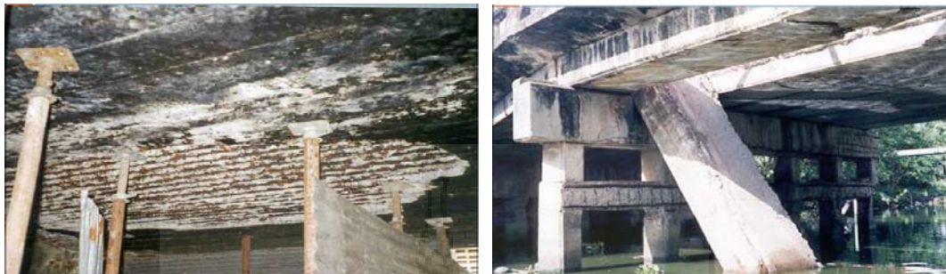
รูปที่ 2.7 ความเสียหายเนื่องจากคลอไรด์โดยเหล็กเป็นสนิมต้นคอนกรีต ที่มา; www.nonyrico.com
