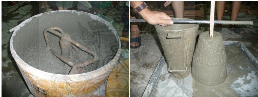
การผสมคอนกรีตและการทดสอบค่าการยุบของคอนกรีต
