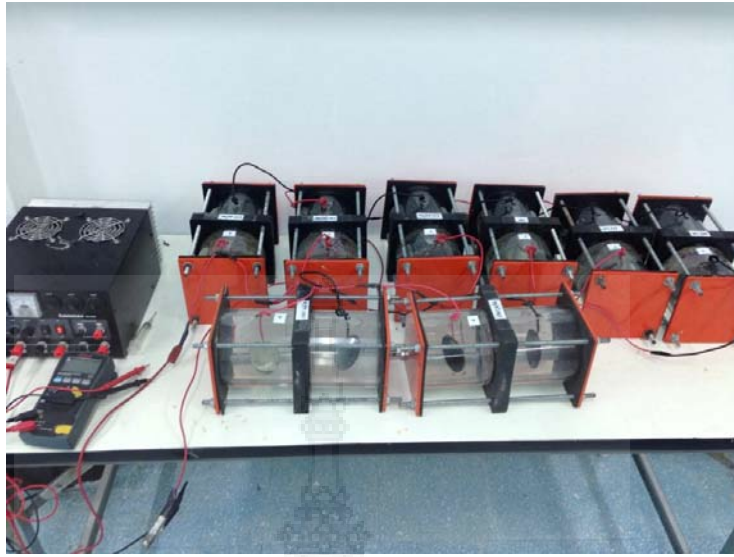
ภาพที่ ค.13 ประกอบและต่อวงจรไฟฟ้าทั้งระบบ
