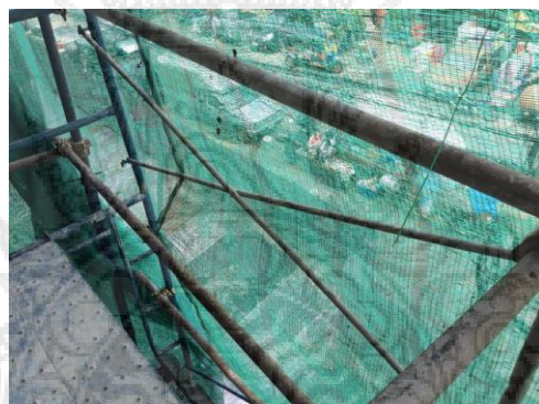
รูปที่ 4.6 ติดตั้งราวกันตกสูงไม่น้อยกว่า 0.90 เมตร
