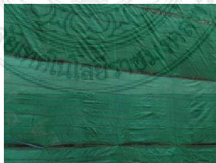
รูปที่ 4.7 ติดตั้งตาข่ายรอบนอกของนั่งร้าน
