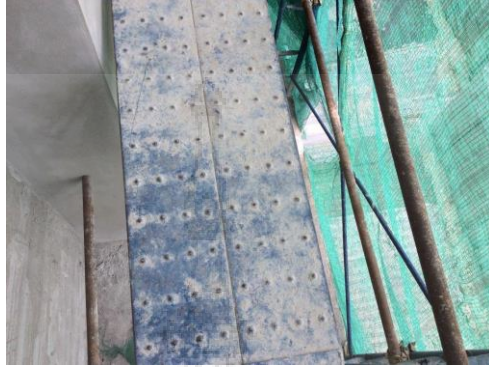
รูปที่ 4.5 ทางเดินบนนั่งร้าน สะอาด ไม่ลื่น
