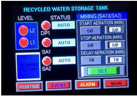
ภาพที่ 1.6 WWTP. Smart Monitoring ขณะกำลังทำงานในส่วนของน้ำ รีไซเคิล
