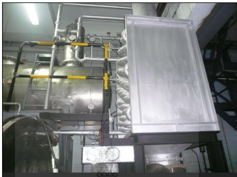
ภาพ 3.4 แสดงภาพไอโคโนมิเตอร์ที่ใช้ในการทดสอบเก็บข้อมูลในสถานที่ทำการทดสอบ
