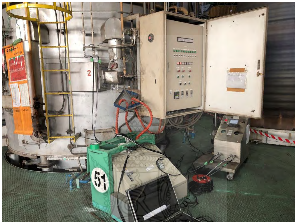
ภาพ 3.24 การติดตั้งอุปกรณ์ตามจุดต่างๆ
