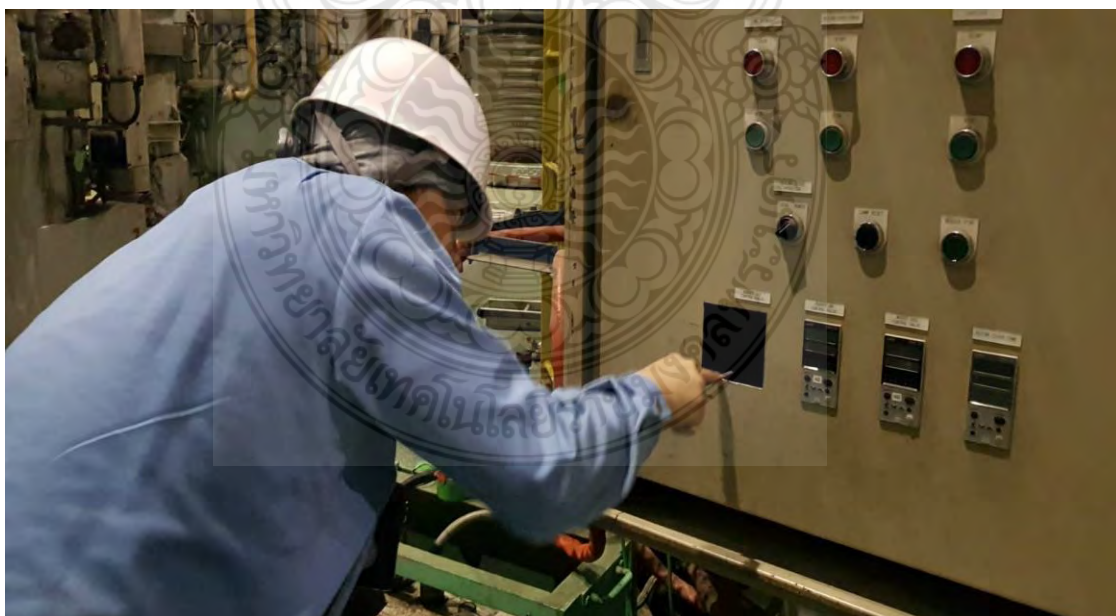
ภาพ 3.16 การขยายขนาดของช่องสำหรับติดตั้งตัวคอนโทรลเลอร์ตัวใหม่
