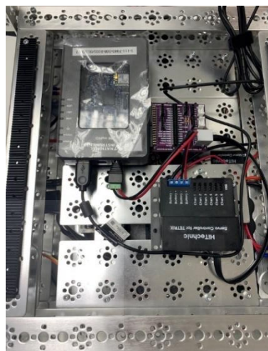
4) เดินสายไฟเข้ากับชุดสวิตช์ แบตเตอรี่บอร์ด myRIO และบอร์ด Servo Controller
