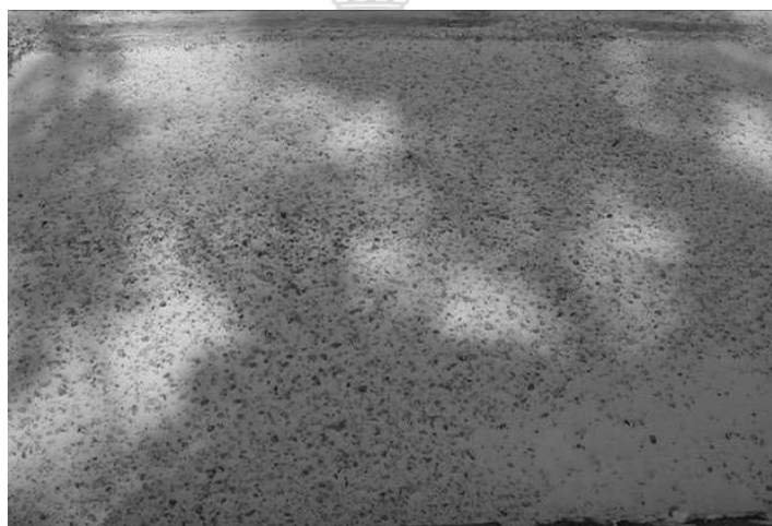
รูปที่ 3.13 การเทผิวหน้าของบล็อกปูพื้นภายนอกอาคารเพื่อลดอุณหภูมิ
